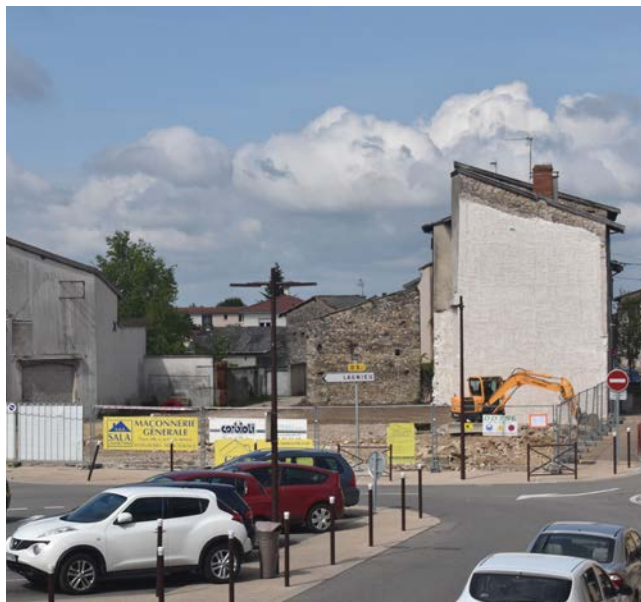
Avril - Juin 2019 : réalisation des terrassements
