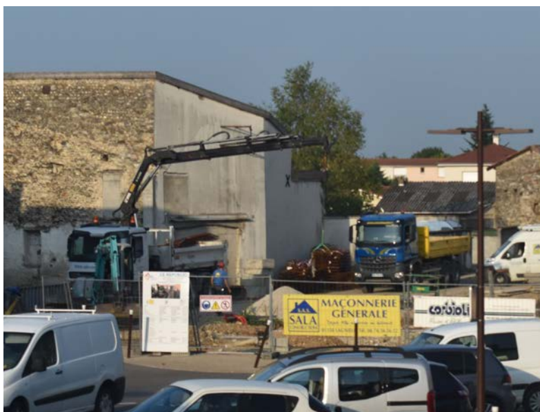
Été 2019 : coulage des fondations
