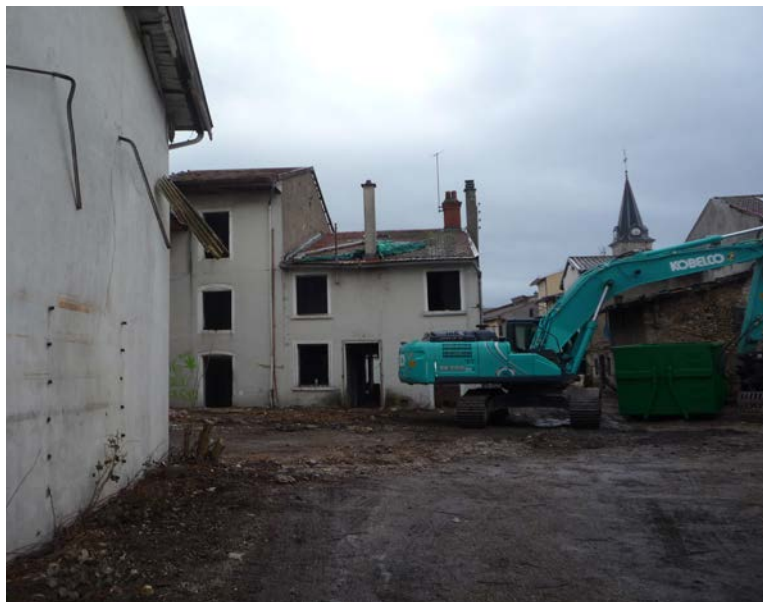
Février - Mars 2019 : lancement des travaux de démolition
